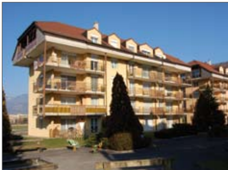
BEX 15-17, RUE DE MONTAILLET
