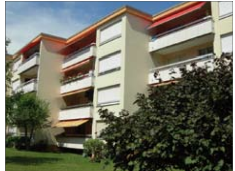
PESEUX 10-12, RUE DE LA GARE
