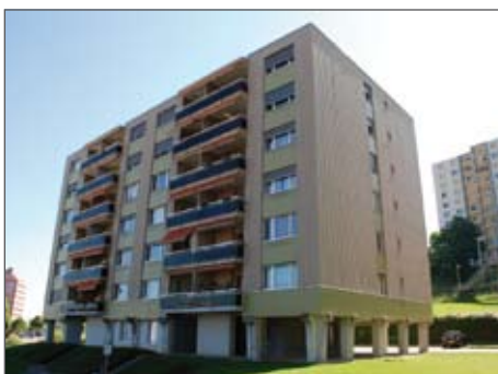
CHAUX-DE-FONDS 34E+F, RUE FRITZ-COURVOISIER
